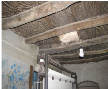
شکل ۱۸- روشنایی مصنوعی در کارگاه
